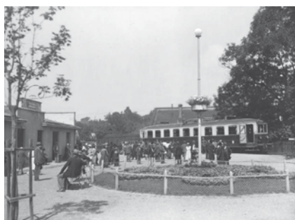
Stacja kolejowa w Wieliczce.
