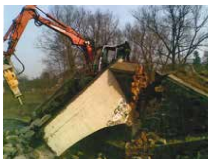
Prace przy naprawie linii kolejowej do Wieliczki. Fot. S. Kumon
