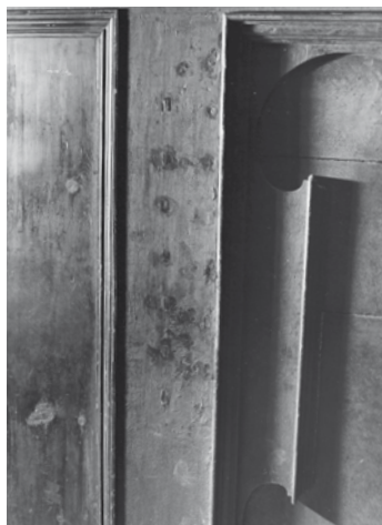
Widoczne w parterowej części szafy ślady zaczopowania otworów na uchwyty żelaznych kluczy rejestrowych manuału i pedału.
