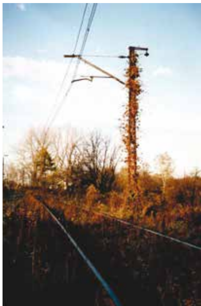
Zarastająca linia kolejowa do Wieliczki.
