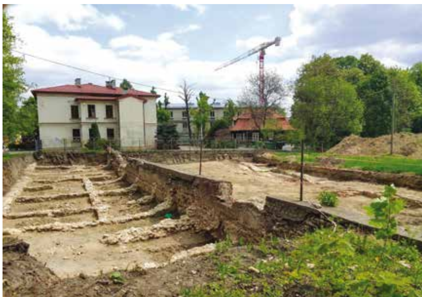
Archeologiczne prace ratunkowe przy ul. Ogrodowej 3 w Krzeszowicach, maj 2022 r. W tle od lewej: budynek dawnego hotelu uzdrowiskowego, nowe skrzydło „Zofii”, willa Japonka. Fot. S. Klich
