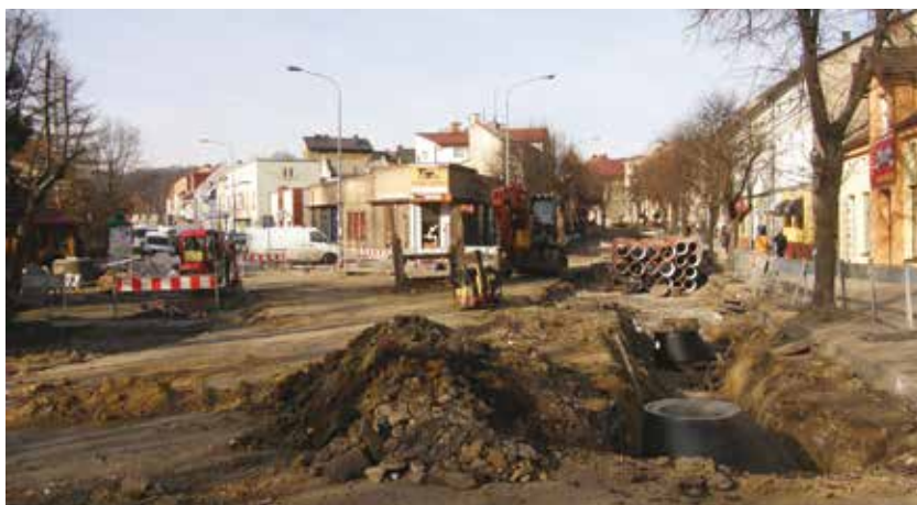
Krzeszowice, ul. Krakowska. Prace przy wodociągu. W dole znajduje się rurmus. Fot. D. Strojnowska
